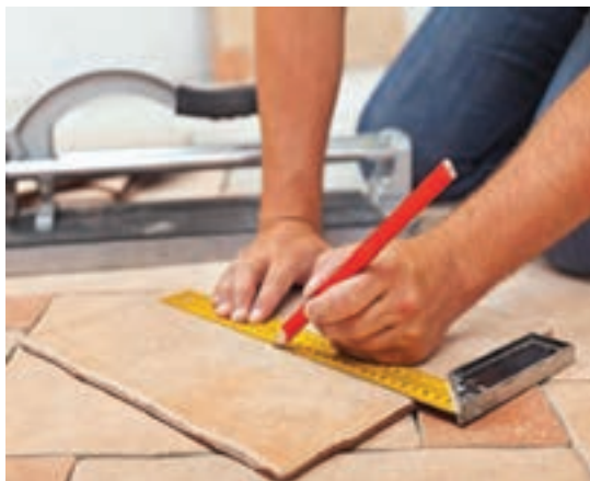
مشخص کردن مسیر برش سرامیک
