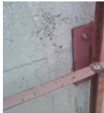
اتصال قطعات زیرسازی سنگ به دیوار
