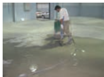
اجرای ملات برای مسطح کردن سطح
