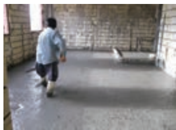
تسطیح فوم بتن قبل از خشک شدن
